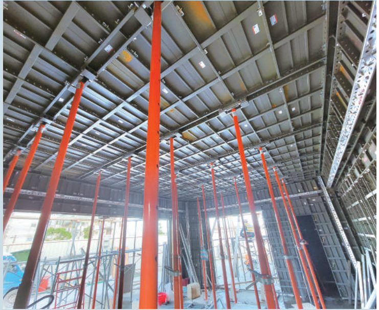
參訪德築集團鋁模板工地 / 鋁模樑版底部 攝影◎鄒靖
