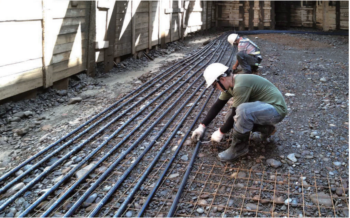
地源管路灌漿前固定 避免灌漿時上浮
