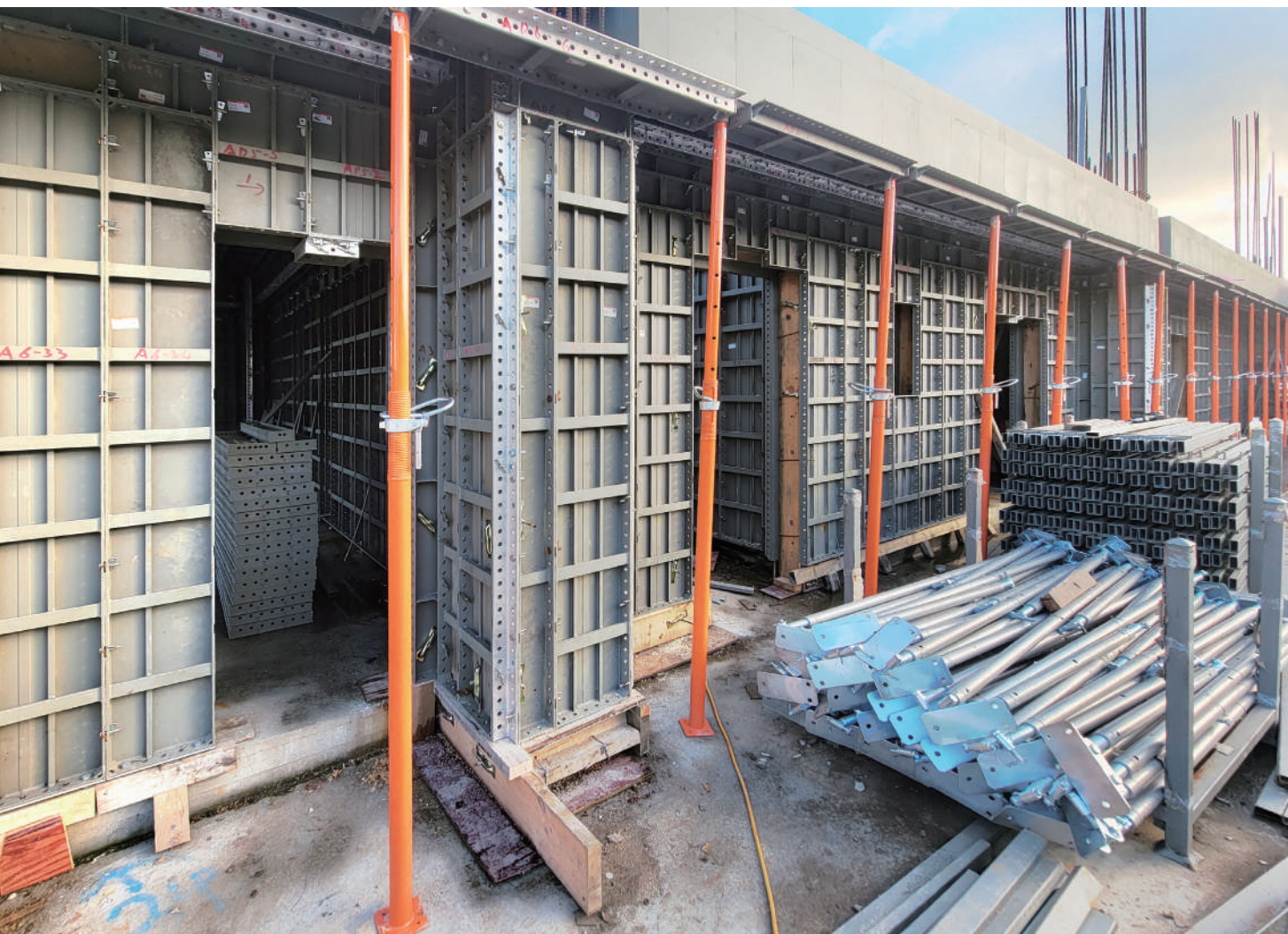
參訪德築集團鋁模板工地 / 鋁模柱牆 攝影◎鄒靖
