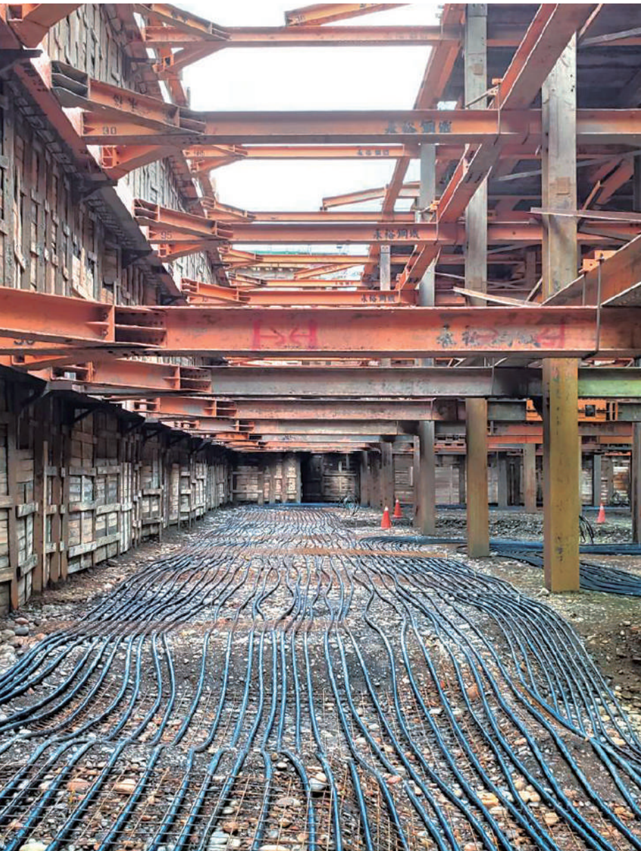
地源管路依序鋪設施工
